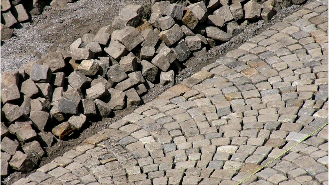
Pflästerung Bagnera in Arbeit.jpg
