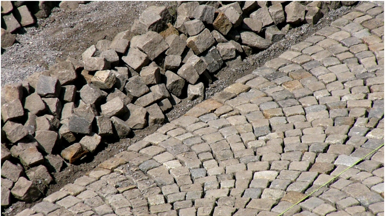
Pflästerung Bagnera in Arbeit.jpg
