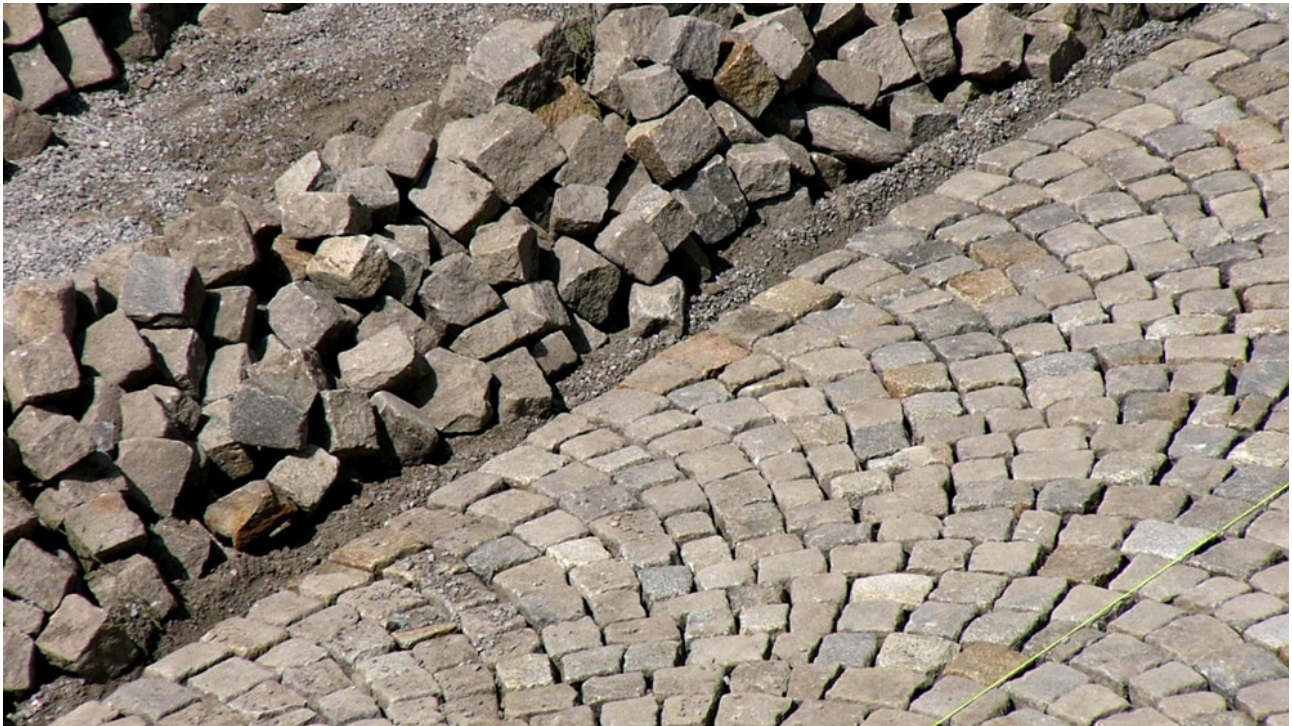
Pflästerung Bagnera in Arbeit.jpg
