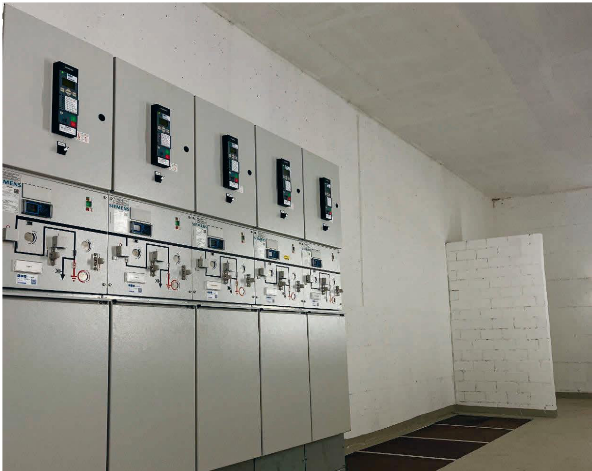
(interruptur compact d'ota tensiun a Tulai, Scuol)
