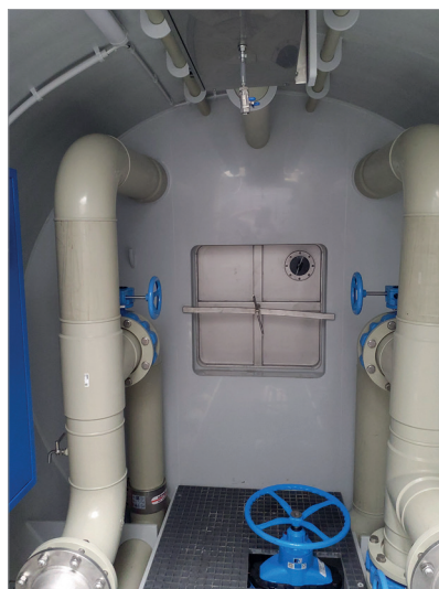
Batschigl da regulaziun (ils purtrets muossan il batschigl installà dal 2021 sü Val Ruschna, Scuol)
