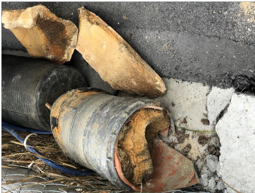
Chanalisaziun Via da Liuns / Mottapitschna: tub impli cun tof
