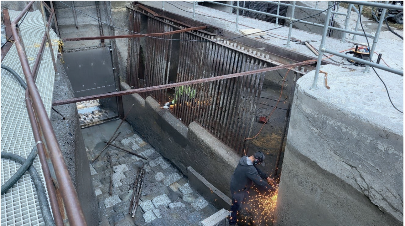
Lavurs vi da rastè grob aint il inchaschamait d'aua da l'ouvra Clemgia in september 2025
