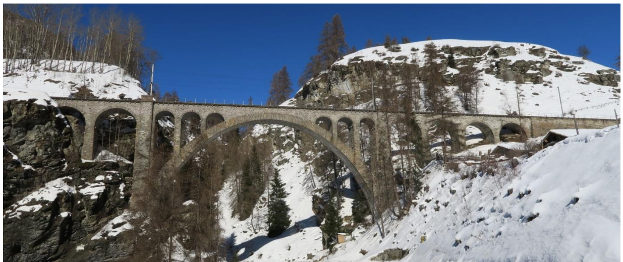
Ilustraziun 1: Viaduct Val Tuoi, km 132.650
