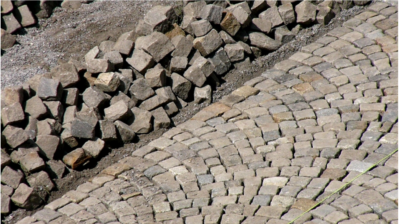
Pflasterung Bagnera in Arbeit.jpg
