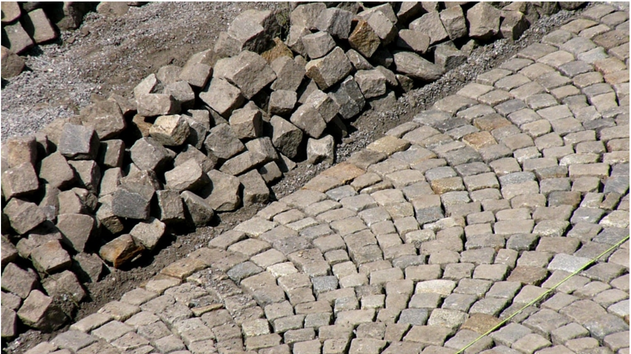
Pflasterung Bagnera in Arbeit.jpg
